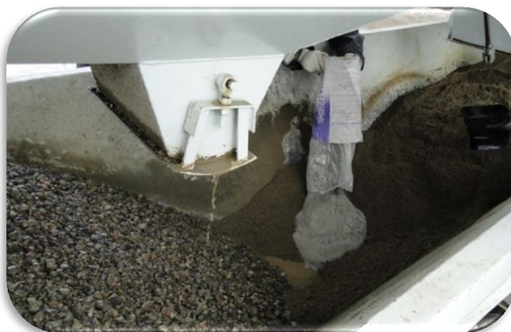
Рис. 1 – Введение добавки КАЛЬМАТРОН-Д в условиях бетонного завода (РБУ)
