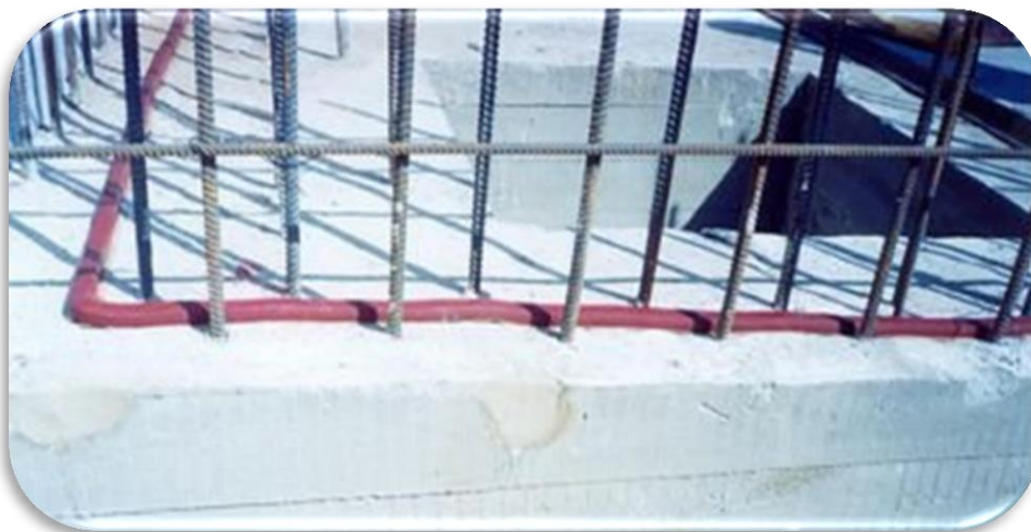
Рис. 4 – Укладка шнура УЛЬТРАПЛАТ
