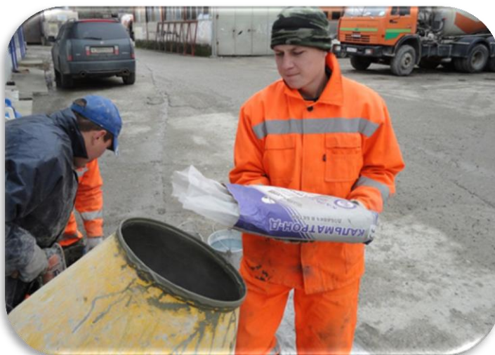
Рис. 2 – Введение добавки КАЛЬМАТРОН-Д в миксер
