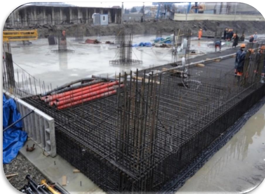
Рис. 3 – Укладка бетонной смеси с добавкой КАЛЬМАТРОН-Д
